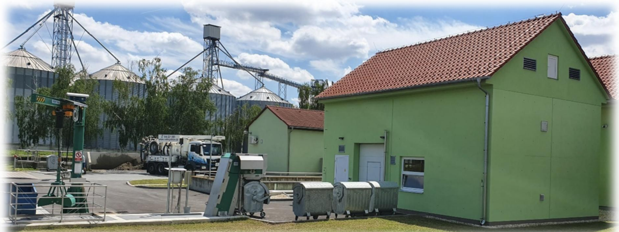
ČOV Slavkov u B., Mechanické předčištění a vstupní ČS
