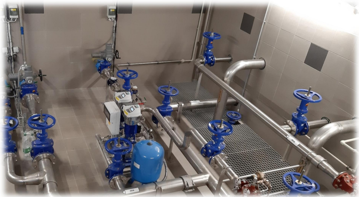
Rozšíření SV Vyškov, II. etapa, větev Švábenická. 1. stavba - detail AK VDJ Moravské Málkovic
