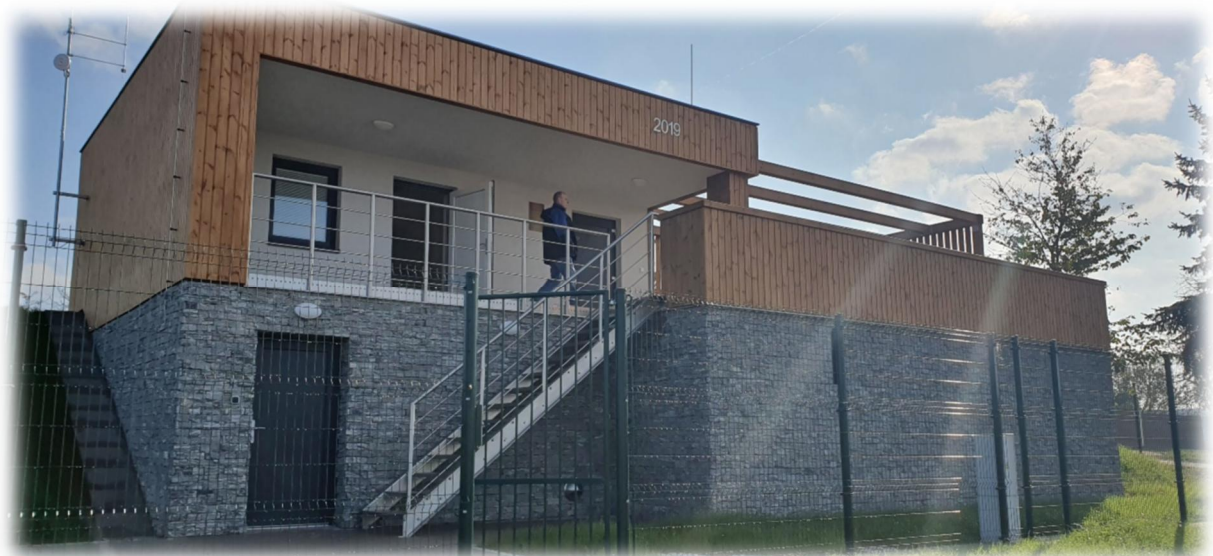
Rozšíření SV Vyškov, II. etapa, větev Švábenická. 1. stavba - VDJ Moravské Málkovic
