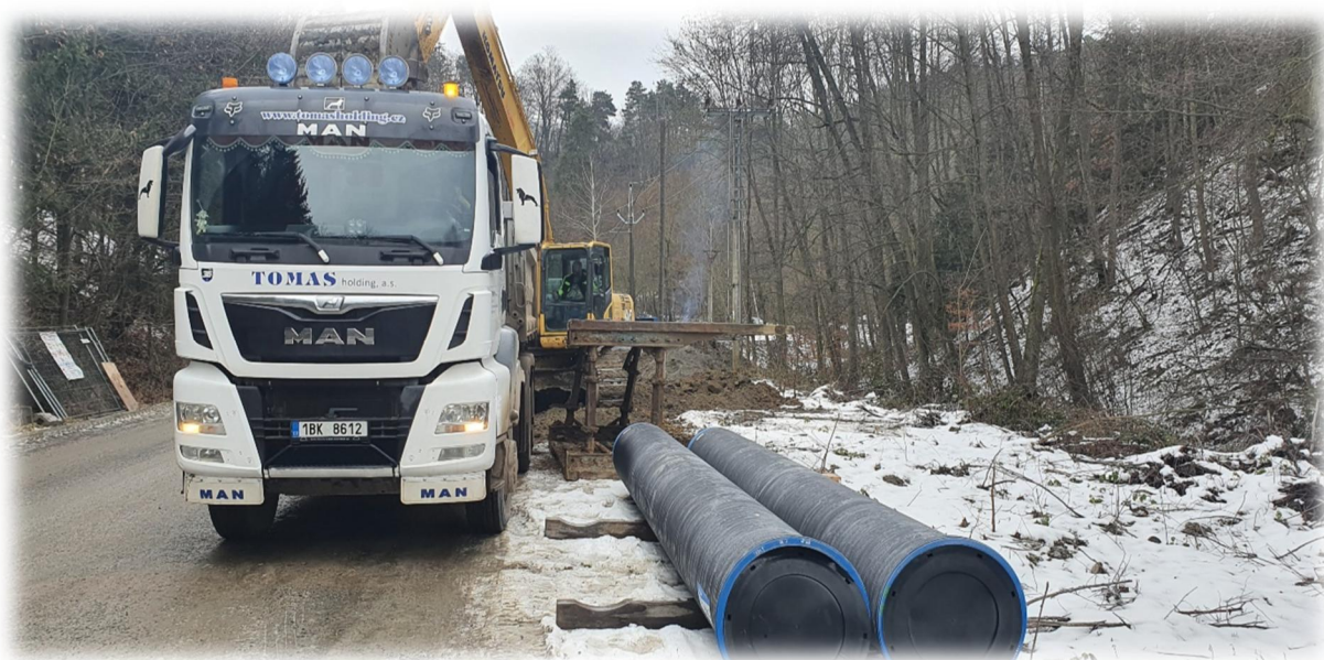
Výměna přívodného řadu surové vody, I. etapa
