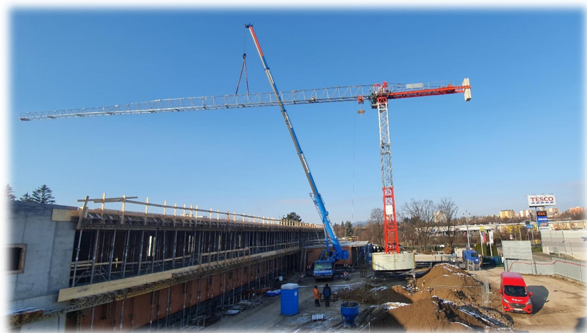
Rekonstrukce areálu společnosti Vodovody a kanalizace Vyškov
