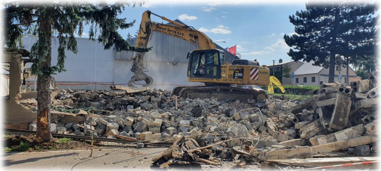
Rekonstrukce areálu společnosti Vodovody a kanalizace Vyškov - demoliční práce
