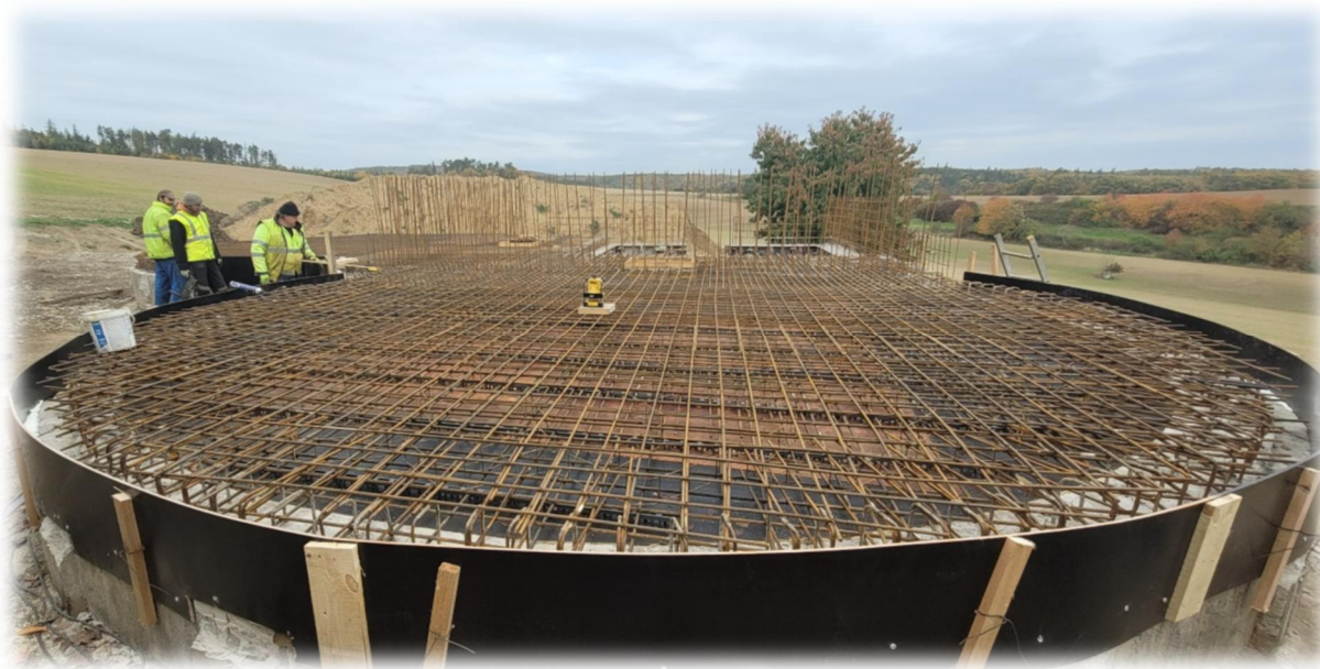
Vodojem Radslavice – rekonstrukce
