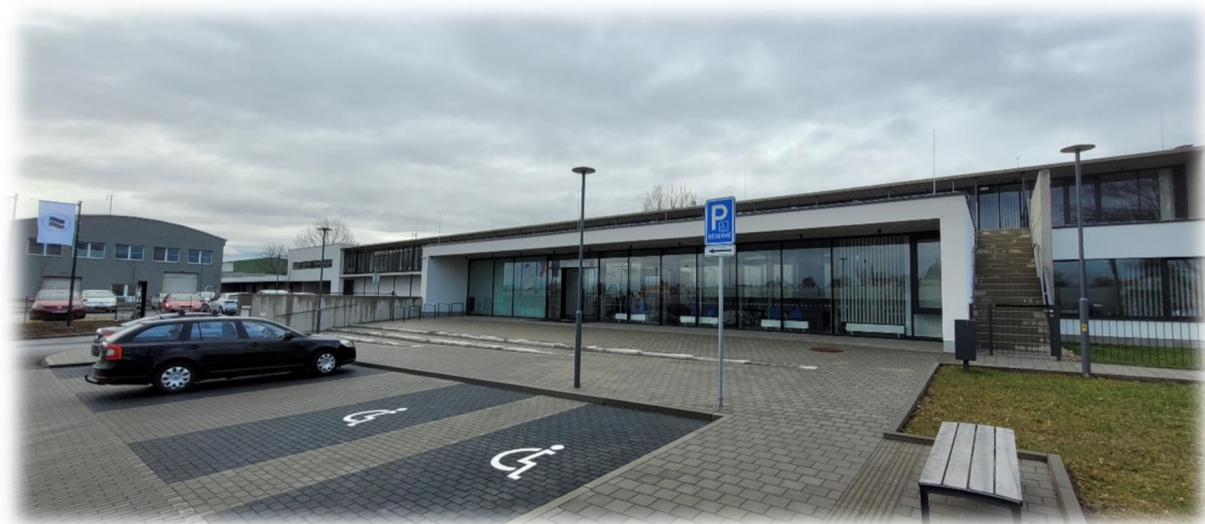
Rekonstrukce areálu společnosti Vodovody a kanalizace Vyškov
