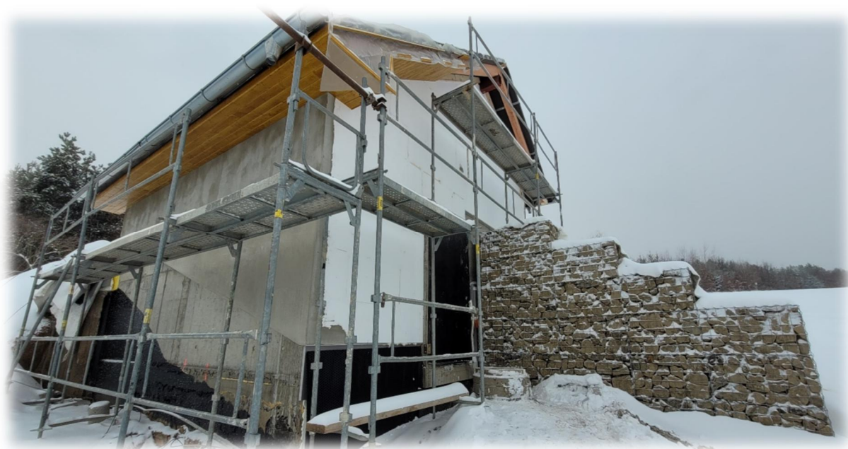
Vodojem Radslavice – rekonstrukce
