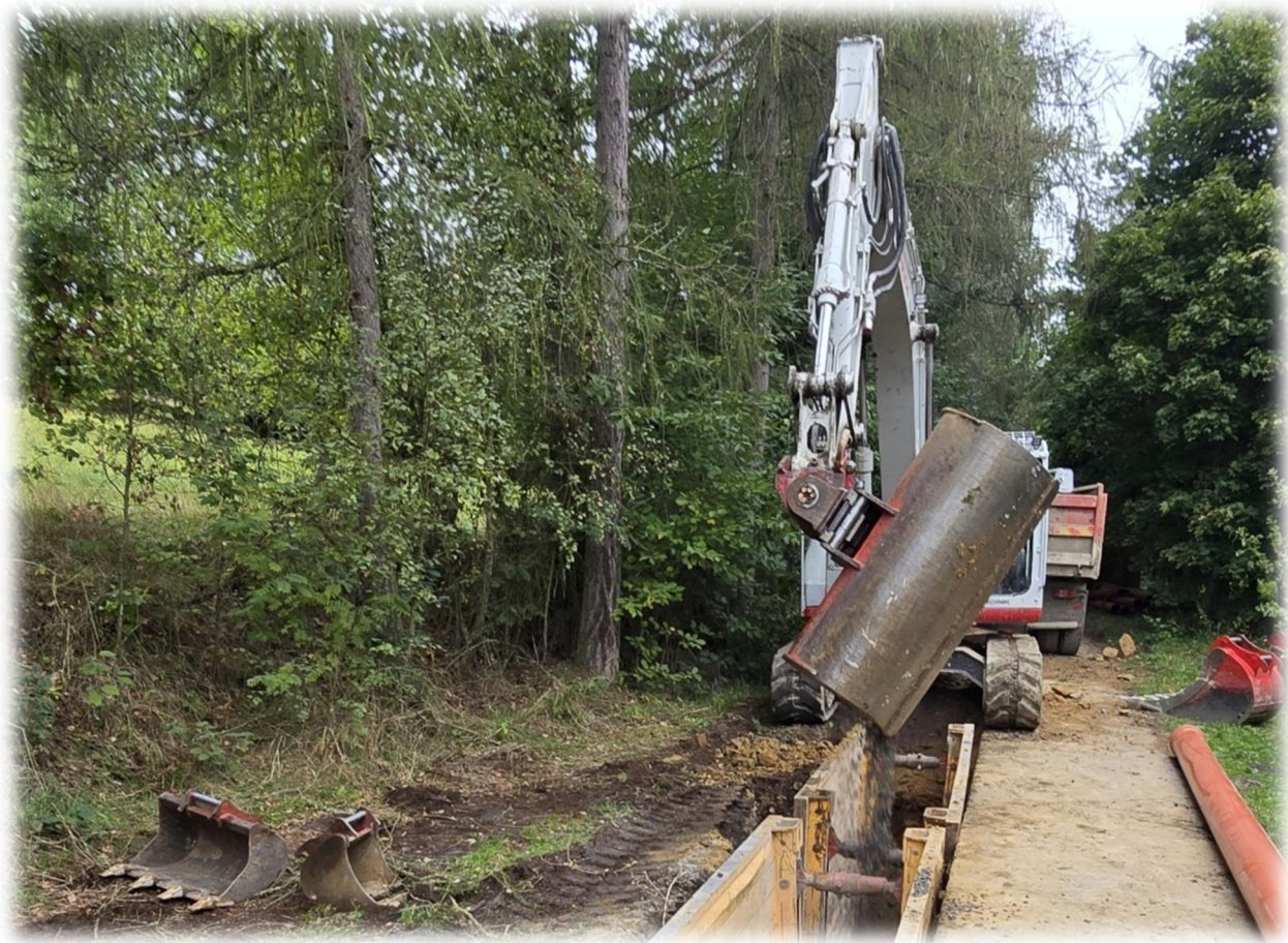
Krásensko – stoková síť a ČOV – pokládka kanalizace
